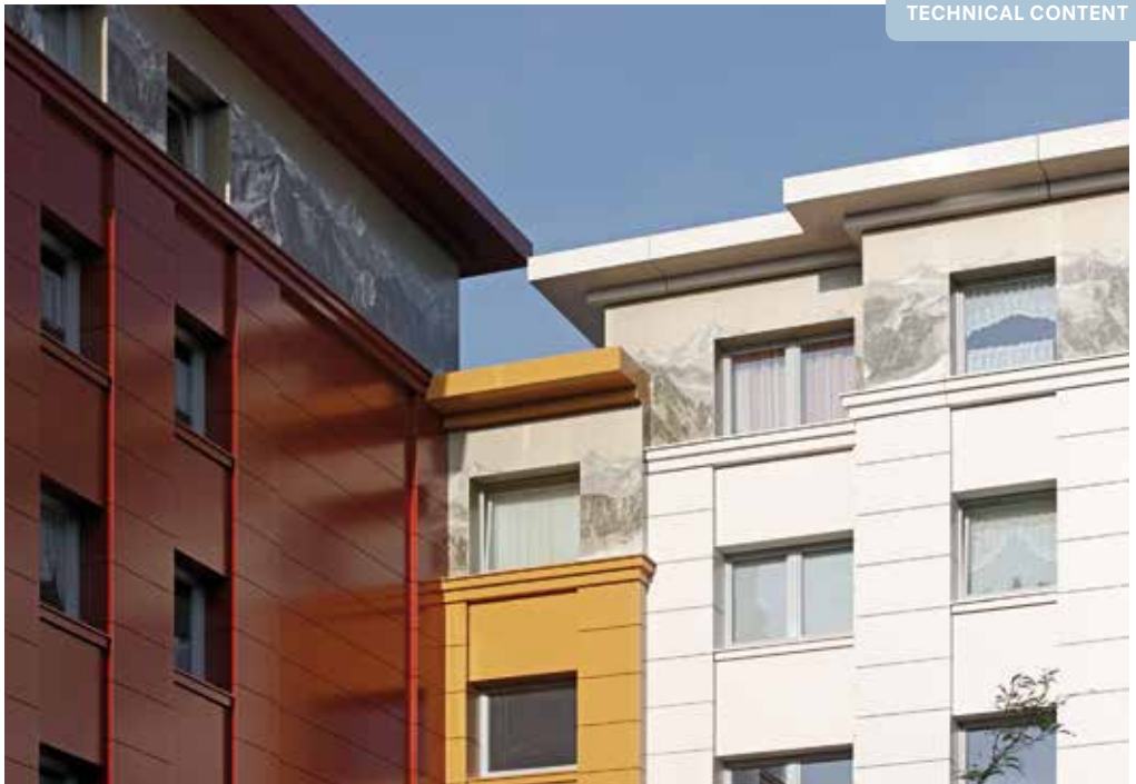
Upper roof edge made of ALUCOBOND® with a fascia forming the transition to the facade Oberer Dachrand aus ALUCOBOND® mit einem Dachgesims als Übergang zur Fassade
