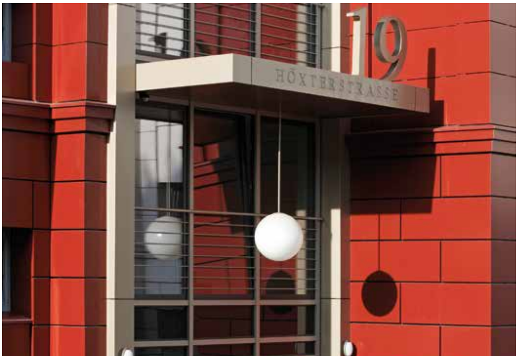
ALUCOBOND® canopy with suspended luminaire; water-bearing level made of ALUCOBOND® ALUCOBOND®-Vordach mit abgehängter Pendelleuchte; wasserführende Ebene aus ALUCOBOND®
