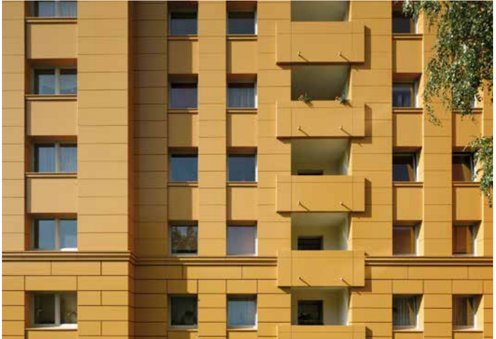
String course ALUCOBOND® cladding along the building at basement height to form an optical dividing line Umlaufende ALUCOBOND®-Verkleidung als Gesimsband zur Unterteilung der Fassade mit Sockelgeschoss
