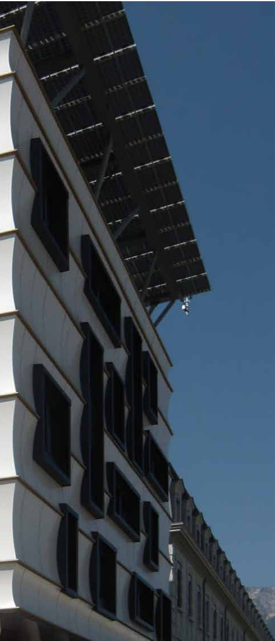
RIVETED / SCREWED to aluminium substructure for vertical / horizontal panel layout GENIETET / GESCHRAUBT auf Aluminium-Unterkonstruktion für vertikale / horizontale Fassadengliederung
