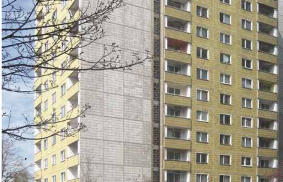
RIVETED / SCREWED to aluminium substructure for vertical / horizontal panel layout GENIETET / GESCHRAUBT auf Aluminium-Unterkonstruktion für vertikale / horizontale Fassadengliederung
