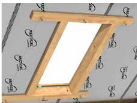
Figuur 13: bijkomende versterking langs de binnenzijde
