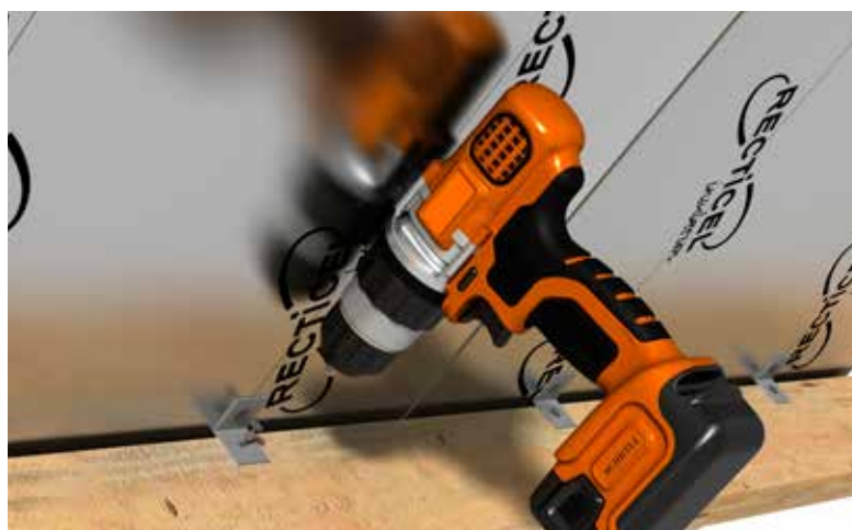
Figuur 8: bevestiging van binnenuit met een L-profiel
